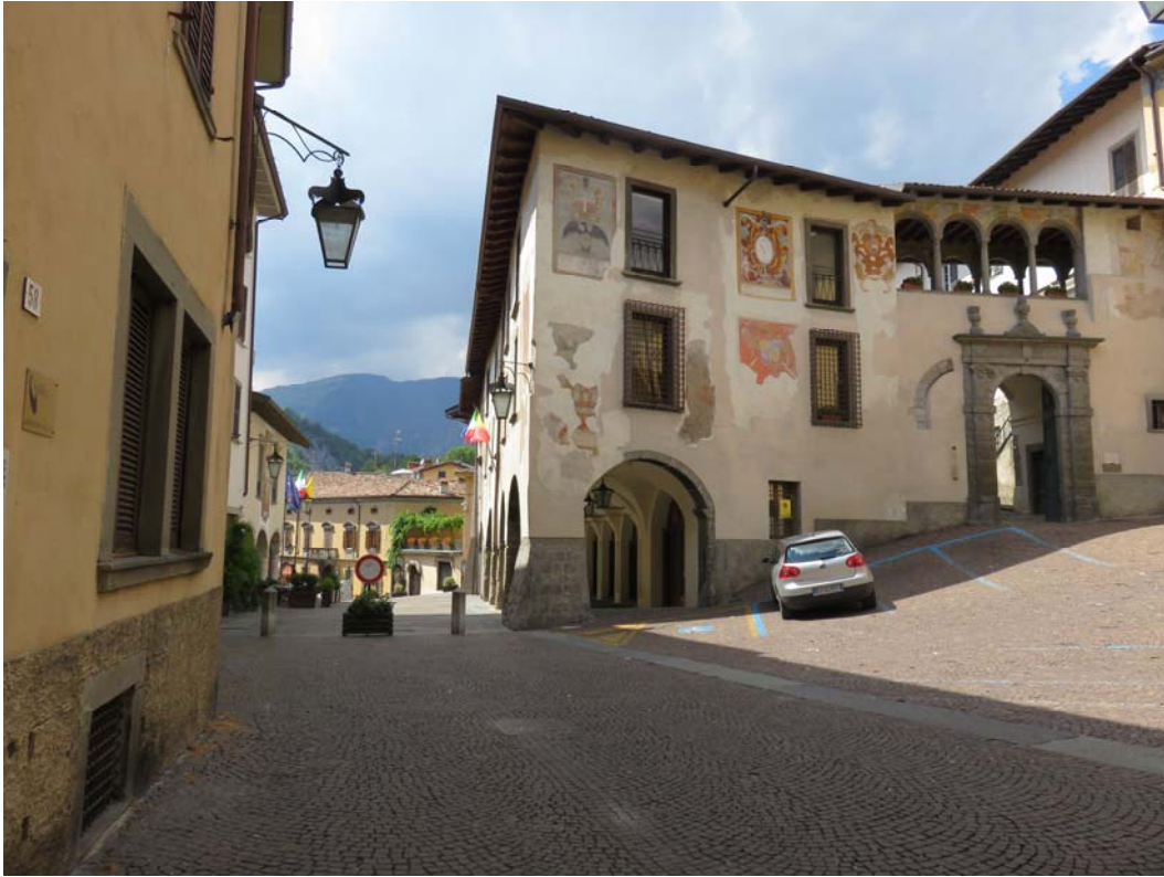
Façade latérale. Nous pénétrerons à l'arrière par la porte de droite.
